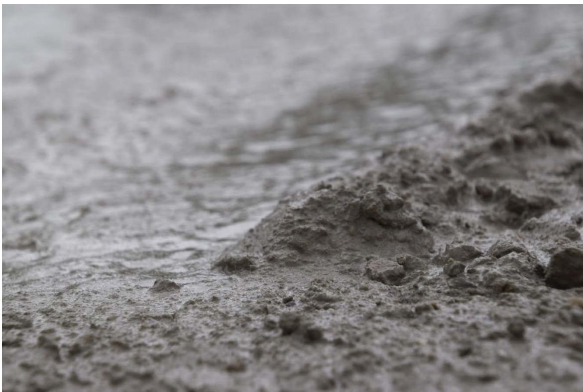
Foto: Detail betonmortel.
